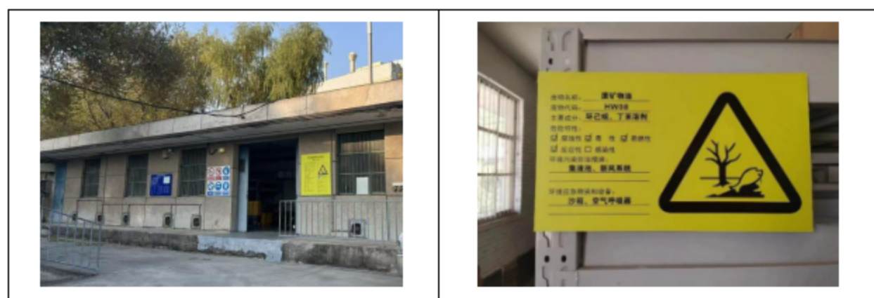
图 4.1-8 危废暂存库现场照片
